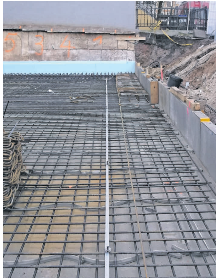
Eine unvergossene Sohlplatte, auf der ein Fundamenterder verlegt wurde.
