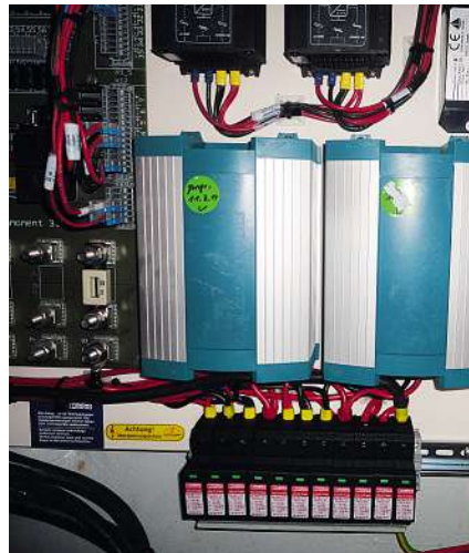
Bild 14: Überspannungsschutzeinrichtungen in der Niederspannungs-Hauptverteilung
