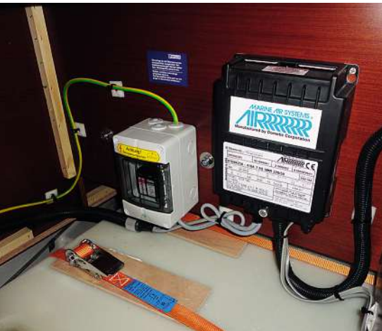
Bild 12: Ansicht der Installation des Überspannungsschutzes der Klimaanlage im Salon 2
