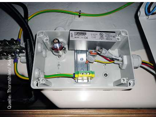
Bild 13: Überspannungsschutz des Radars (während der Montage)
