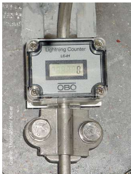
Bild 15: Blitzstromzähler zur Erfassung von Blitzereignissen
